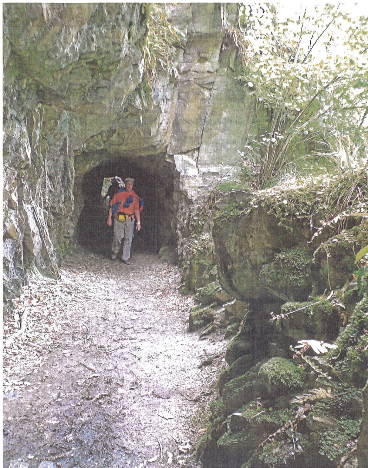
Immer wieder ein Highlight im Hahnenbachtal: Wanderweg durch einen kleinen Stollen, der für den Schiefer-Abtransport mit Schmalspurloren gebrochen wurde. Die Schiefergrube ist auch 2014 wieder im Programm. Foto: Seibert
